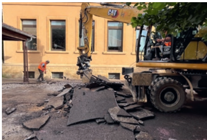
Le début du décaissement de l'enrobé existant par l'entreprise, au démarrage des travaux en juillet, après la fin de l'école.
